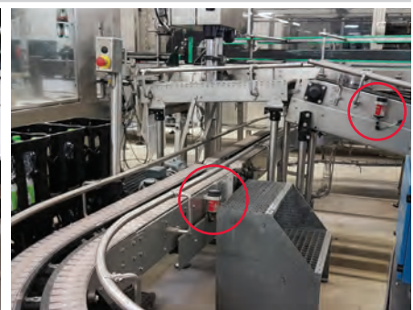
Lubrificação de correntes do transporte de caixas depois do empacotador e do controlo de caixas cheias
