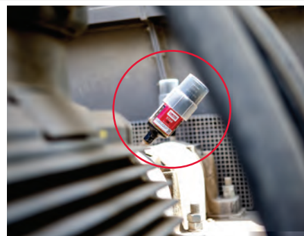
Lubrificação de um exaustor ou ventilador
