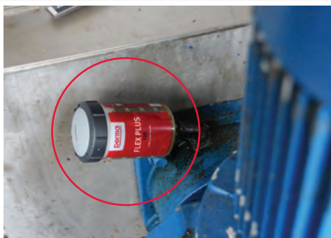
Lubrificação dos rolamentos de uma bomba
