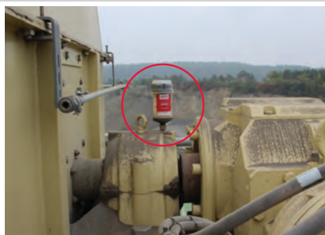
Lubrificação dos rolamentos no elevador quente
