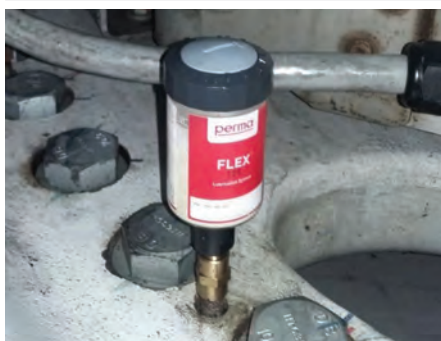
Lubrificação de dentes de engrenagem de azimute
