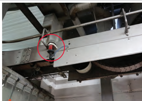
Lubrificação de correntes no transporte de caixas para o ejetor de caixas
