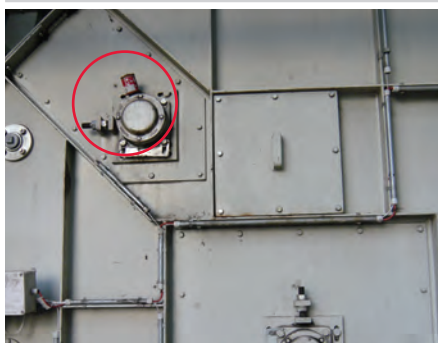
Lubrificação de flange do mancal de um elevador de baldes
