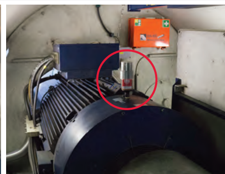
Relubrificação automática do rolamento do gerador
