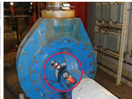
Lubrificação do eixo motriz de uma bomba
